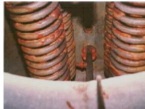
Fig.C.1. -Ejemplo de corrosión en el interior de un interacumulador
