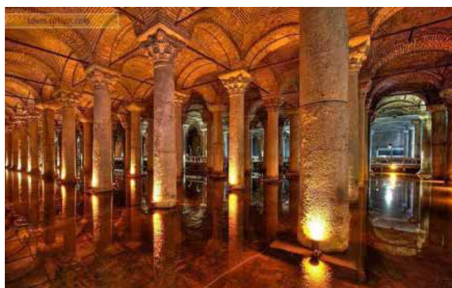
El Yerebatan Sarayi en Turquía, es considerado la cisterna de almacenamiento de aguas lluvia más grande del planeta, con una capacidad de 80 mil metros cúbicos, construida en el año 532
