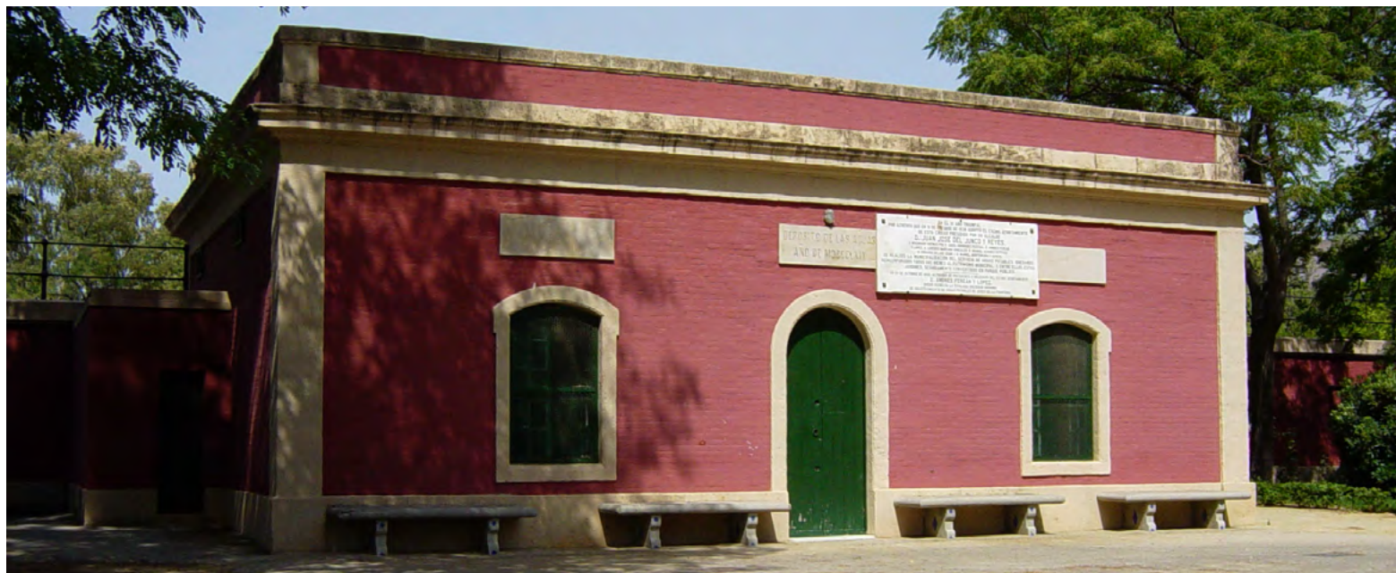
Depósito de Aguas de Tempul, Jerez de la Frontera (Cádiz)
